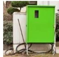
Die Länge der Anschlussleitung ist so kurz wie möglich zu wählen, max. Länge bis 30 m zwischen Übergabepunkt/Anschlusspunkt zum Zähler, Querschnitt mindestens 16 mm<sup>2</sup> Cu.
